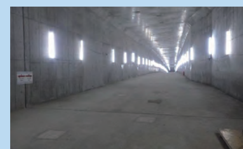
2工区(トンネル内)
