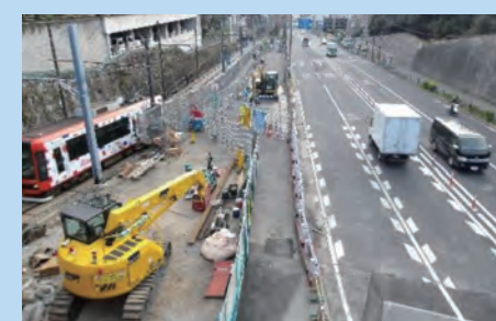
1工区(明治通り)
