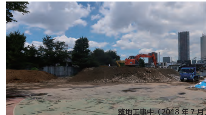
整地工事中(2018年7月)
