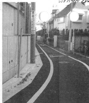
音大前道路整備
