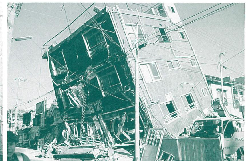
ピロティの柱が折れ傾いたビル
