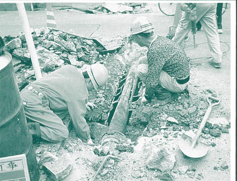
水道管の復旧作業、管に大きな亀裂が見えます
