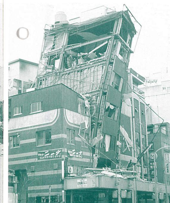
大きく変形した鉄骨造のビル
